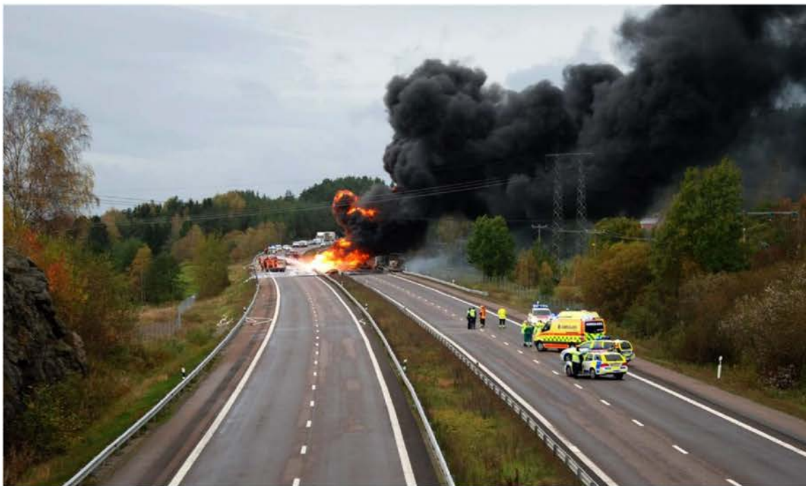
Bild: Brand i tankbil på E6 i höjd med Kareby 2011. En person avled och vägen blev avstängd. Ny asfalt fick läggas då den gamla hade smält och runnit ner i mittremsan samt runnit ned för en slänt.
