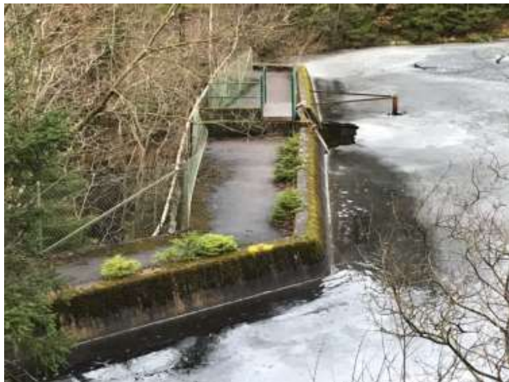
Översikt anläggningar vid Drypesjön.
