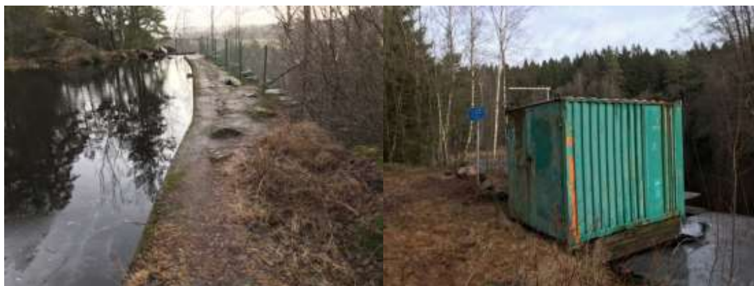
Anläggningar vid Kvarndammen.
